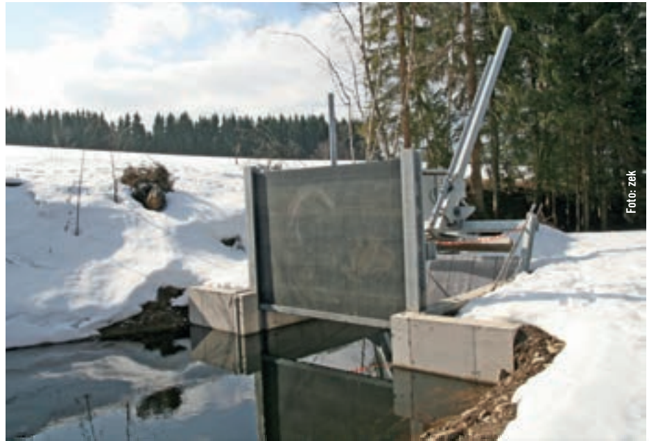
Am Ende des Freispiegelkanals wurde ein vollautomatisches Fallschütz, sowie der Feinrechen mit einer Teleskoparm-Rechenreinigungsmaschine installiert. Sämtliche Stahlwasserbauteile stammen von der Firma Krönauer Maschinenbau aus Geiersthal bei Teisnach. Vor allem der Feinrechen hat es in sich: Er wurde komplett in Edelstahl ausgeführt, damit er möglichst widerstandsfähig gegen das relativ saure Milieu des Triebwassers ist. Außerdem wurde nach den Plänen von Christoph Pfeffer ein extrem enger Stababstand von unter 1 cm realisiert.
