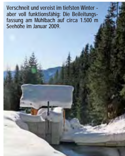
Das Krafthaus wurde oberhalb des Rantenbachs in steilem Gelände angelegt. Besonders aufwändig gestaltete sich die Errichtung des Zufahrtsweges. Im Inneren befindet sich der Maschinensatz. Die Turbinenachse liegt auf 1068 m Seehöhe.
